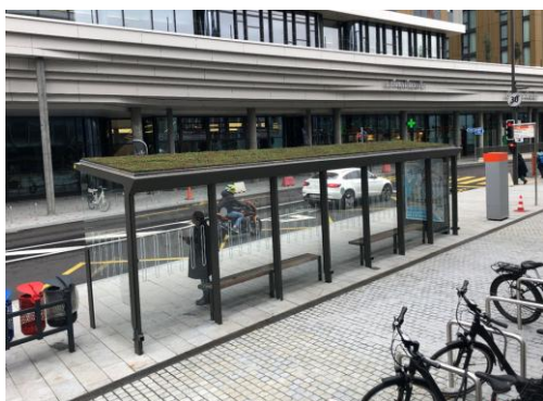
Les nouveaux abribus avec toiture végétalisée
